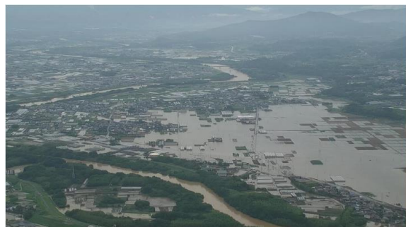
令和5年6月・台風2号の被害の様子
